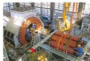
大型発電機の定期解体点検
