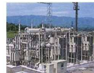
重電機器プラント塗装
