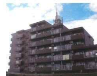
大型マンションの再塗装
